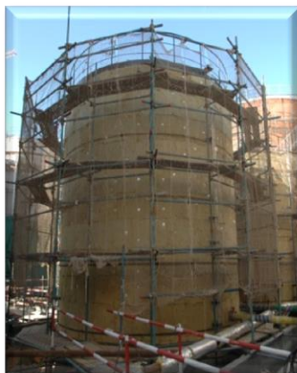
Нанесение материала ELASTUFF на градирни
