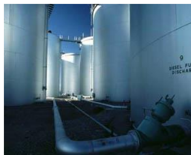
Нанесение ELASTUFF на нефтехранилища
