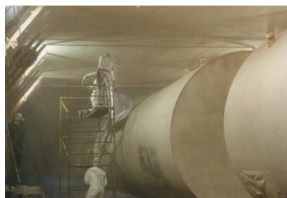
ELASTUFF – обработка резервуаров
