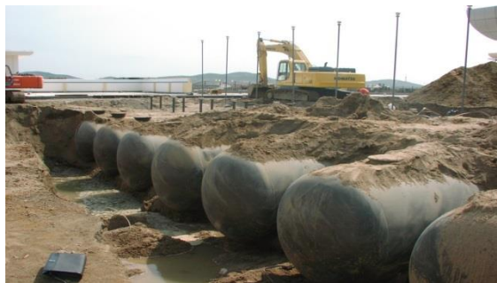
Нанесение материала ELASTUFF на нефтяные цистерны
