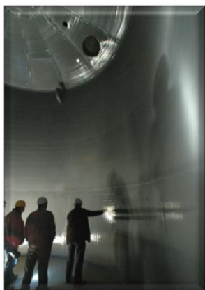
Гидроизоляция внутренней поверхности цистерны
