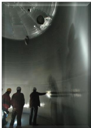
Гидроизоляция внутренней поверхности цистерны
