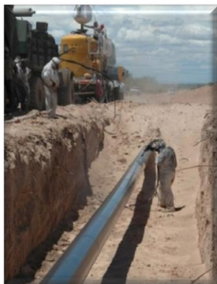
Нанесение материала ELASTUFF 300 на трубопровод
