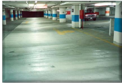
Применение UNIFLEX 3000 в подземном паркинге
